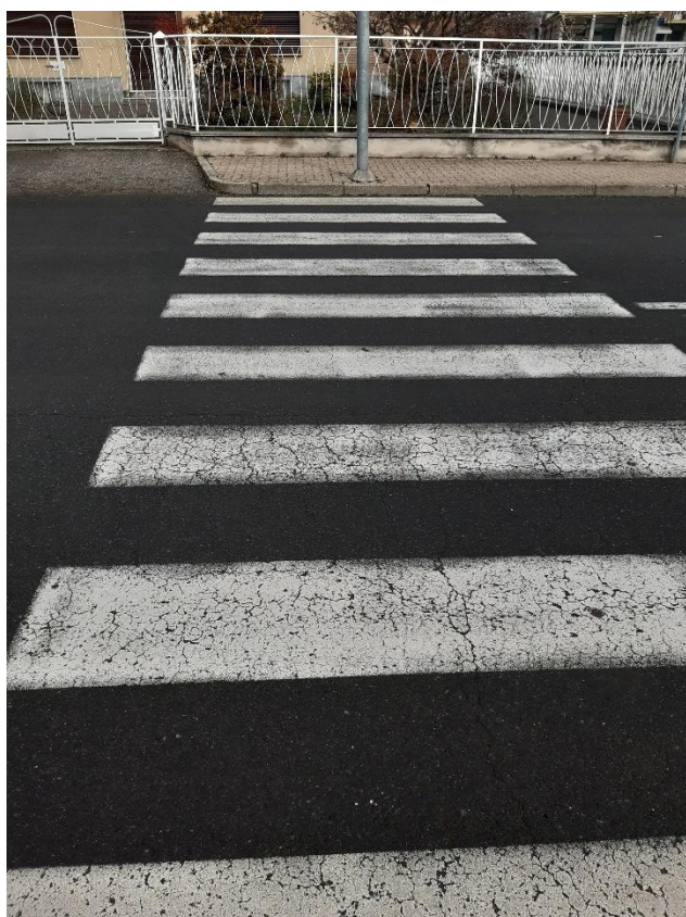
FOTO 3 - Via Marconi attraversamento
