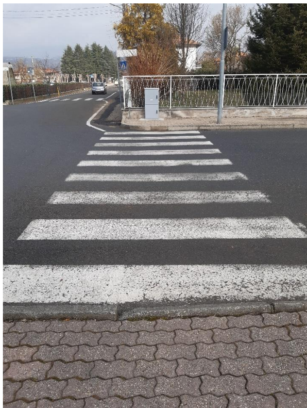
FOTO 1 - Via Marconi attraversamento
