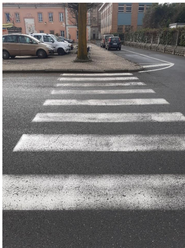
FOTO 2 - Via Marconi attraversamento
